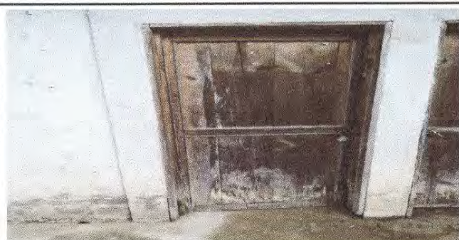
Foto 5: Sustitución de puerta
