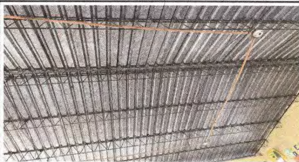
Foto 8: Sustitución de lamparas tipo LED + Reparación de cableado electrico
