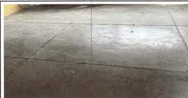
Foto 6: Sustitución de piso cerámico
