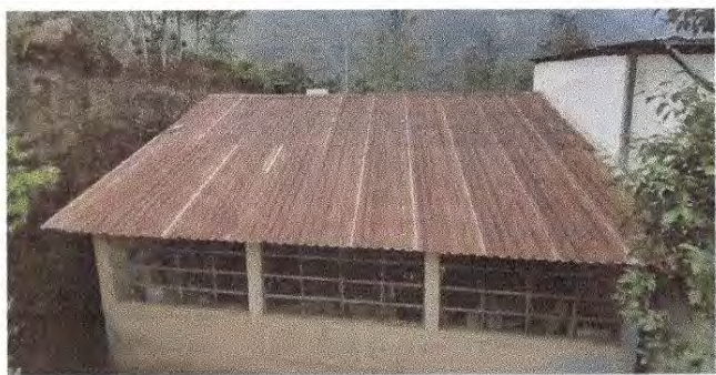
Foto 1: Sustitución de lámina, por lámina troquelada aluzinc calibre 26 + Sustitución de capote de lámina para lámina troquelada + Sustitución de elementos de fijación
