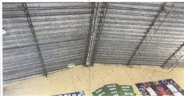
Foto 2: Mantenimiento a estructura de soporte de metal
