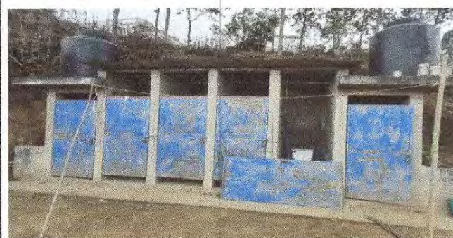
Foto 4: Mantenimiento a estructura (lijado y aplicación de pintura) + Sustitución de chapa
